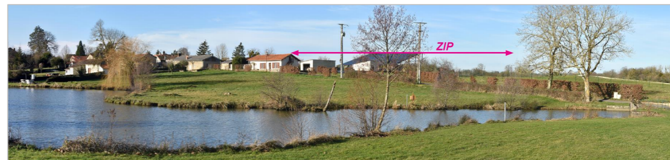
Aux abords de l'étang du Payroux, à Mauprévoir, des vues lointaines s'ouvrent (Source : ENCIS Environnement)
